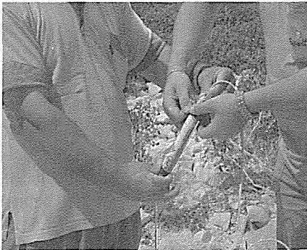
Resim.4.Kapsüle duyarlı ile infilaklı fitilin irtibatlandırılması
