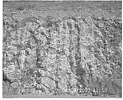
Resim.1. Hatalı Delme Uygulaması (Sivas-Yıldızeli Yol Çalışması.) Kaynak. Mehmet Güler, İzmir
