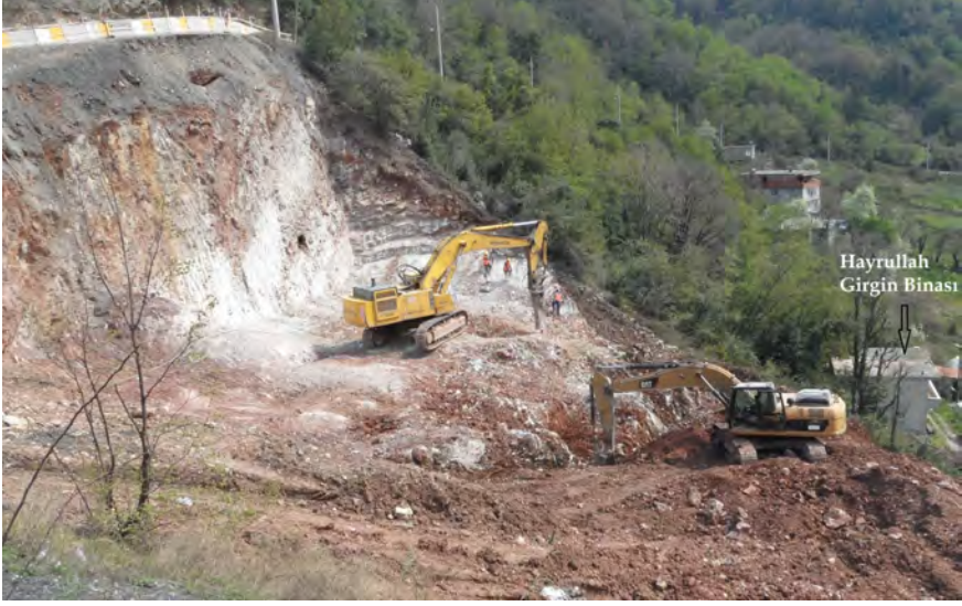
Şekil 3 Orta ayak-1 yerinde iş makineleri ile başlanmış kazının görünümü
