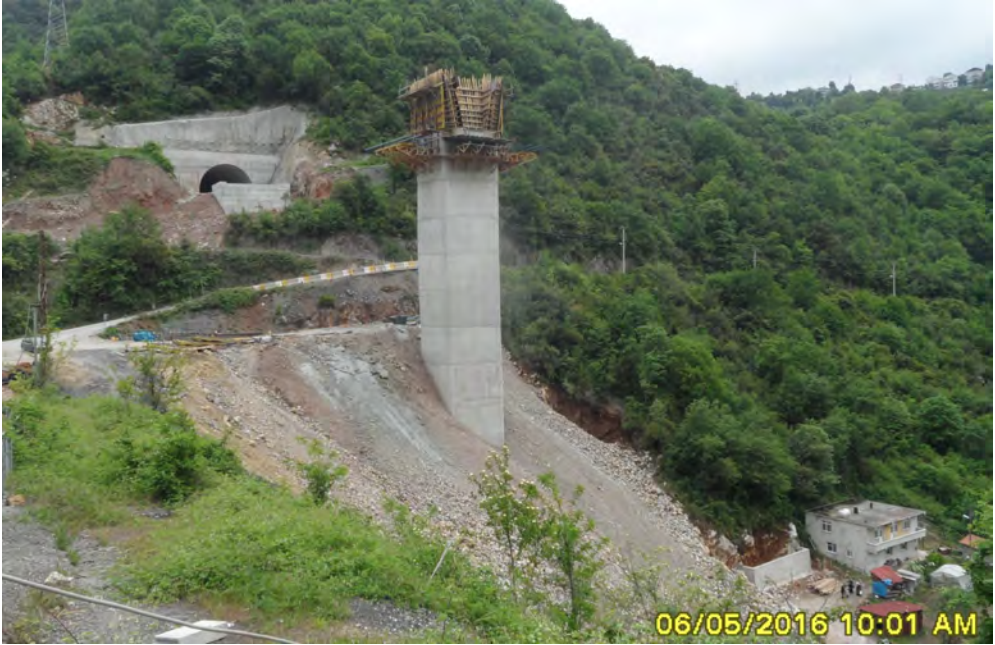
Şekil 16 06 Mayıs 2016 tarihinde Orta Ayak-1 inşaat durumu
