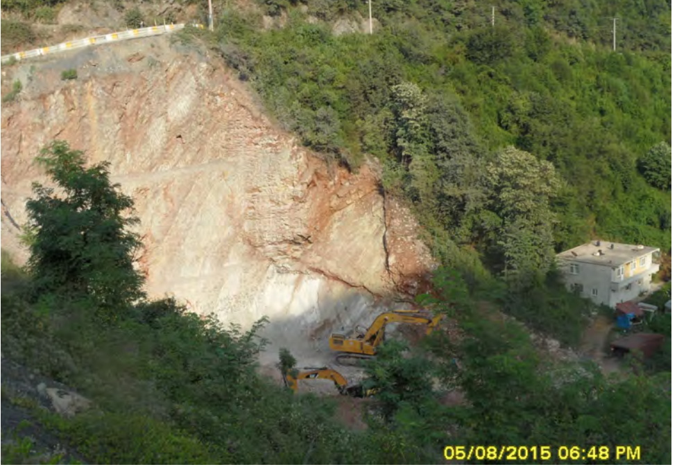
Şekil 14 Orta Ayak-1'in 05 Ağustos 2015 tarihinde üçüncü basamak kazı aşaması
