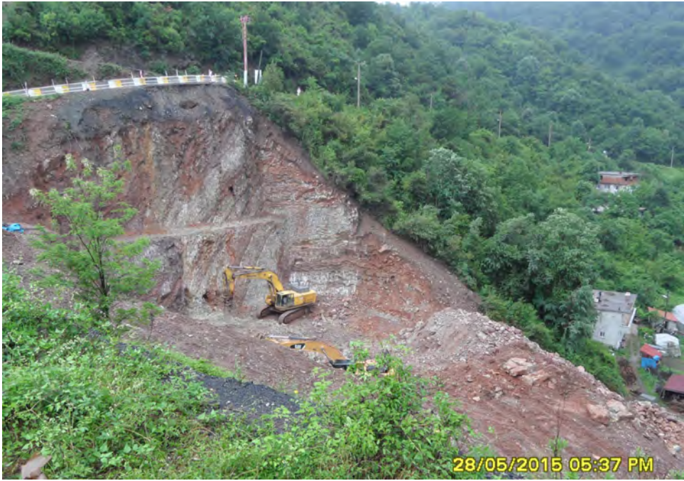
Şekil 13 Orta Ayak-1'in 28 Mayıs 2015 tarihinde ikinci basamak kazı aşaması
