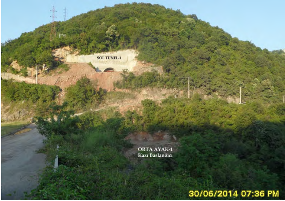
Şekil 1 Orta Ayak-1 kazı yeri ile Sol Tünel-1'in görünümü
