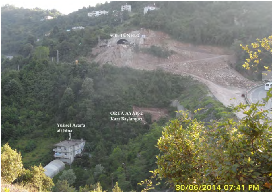
Şekil 2 Orta Ayak-2 kazı yeri ile Sol Tünel-2'nin görünümü
