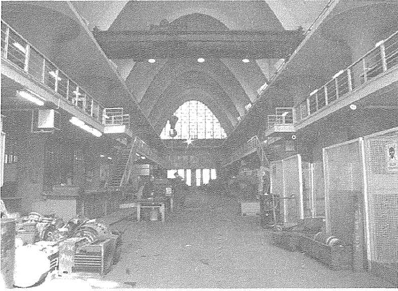
Şekil 7. Elektrik Atölyesinden genel görünüş.
