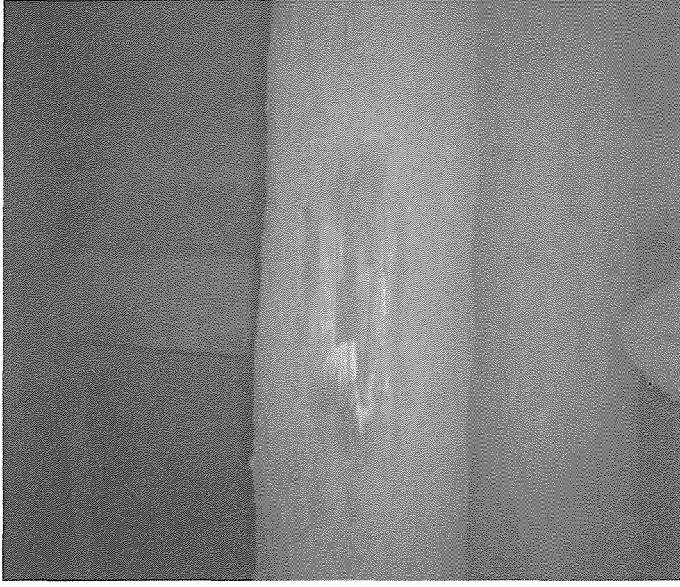
Şekil 12. Kül püskürtme uygulamasının ahşap tahkimat direğindeki katman olarak kaplamasının görünümü.
